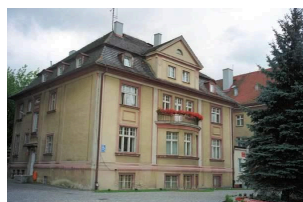
Nr 0742 · 56 P · gebaeude · Drittel Kap. 49 Gebäude in Neustettin 2007 Vorschlag · Original erbeten
