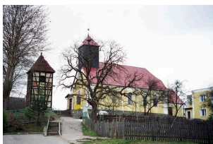
Nr 1077 · 46 P · gebaeude · Drittel Kap. 84 Wurchow 2008 Vorschlag T3-7 ganz aufgenommen (Mittel 46 ab Schwelle 40)
