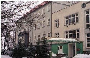
Nr 0881 · 36 P · gebaeude · Vignette Kap. 48 Ein Spaziergang durch das winterliche Neustettin im Februar 2006 nicht im Lesebuch
