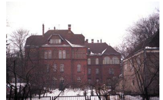
Nr 0900 · 36 P · gebaeude · Vignette Kap. 48 Ein Spaziergang durch das winterliche Neustettin im Februar 2006 nicht im Lesebuch
