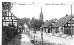
Nr 0301 · 61 P · historisch · Drittel Kap. 14 Ratzebuhr Vorschlag · Personen: Rechte prüfen · Original erbeten
