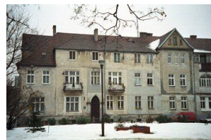
Nr 0911 · 36 P · gebaeude · Vignette Kap. 48 Ein Spaziergang durch das winterliche Neustettin im Februar 2006 nicht im Lesebuch
