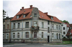
Nr 0716 · 66 P · gebaeude · Drittel Kap. 49 Gebäude in Neustettin 2007 Vorschlag · Original erbeten
