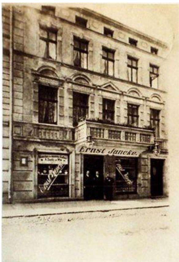
„Geschaeftshaus Ernst Jancke in Tempelburg mit Schaufenstern und Firmenschriftzug ueber dem Erdgeschoss. Hochformatige Sepiaaufnahme von 273 Pixel Breite.“ (Beschreibung des Herausgebers)
