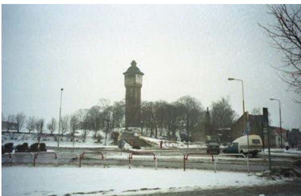
Wasserturm auf dem Scheunenberg.
