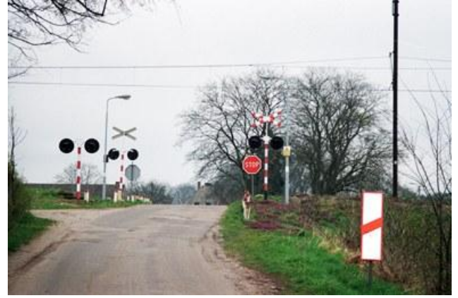
38 - „Unbeschränkter Bahnuebergang an einer Landstrasse bei Bahrenbusch mit Andreaskreuz, Lichtzeichen und Baken, 2008. Farbaufnahme von 390 Pixel Breite.“ (Beschreibung des Herausgebers)
