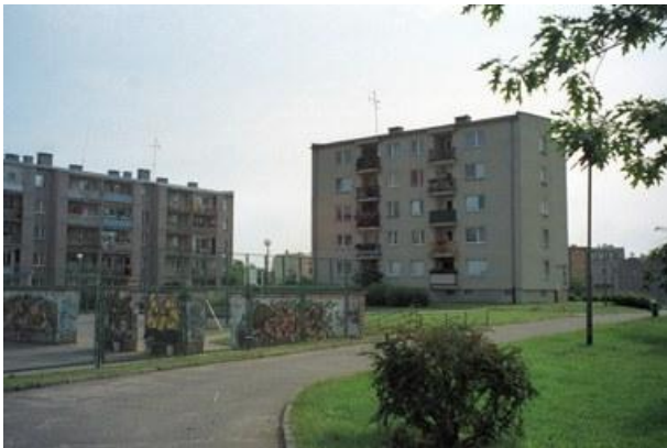
„Plattenbauten mit Gruenflaechen und Strasse in Neustettin, 2007. Farbaufnahme von 380 Pixel Breite.“ (Beschreibung des Herausgebers)
