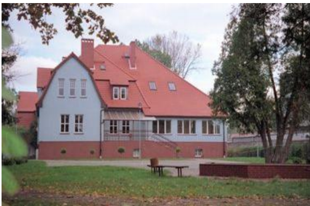
Das ehemalige Offizierskasino in der Sassestraße
