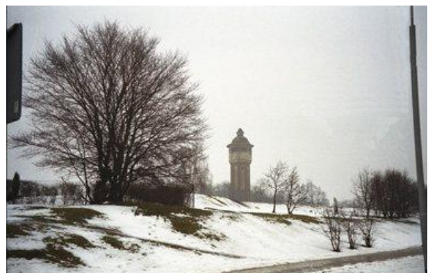
Wasserturm auf dem Scheunenberg.
