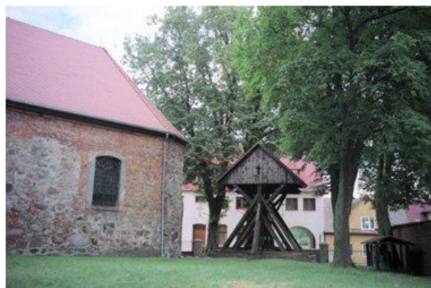
„Feldsteinkirche Tempelburg mit dem freistehenden hoelzeren Glockenturm daneben, 2007. Farbaufnahme von 380 Pixel Breite.“ (Beschreibung des Herausgebers)
