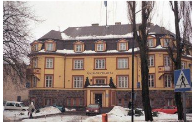
Bank Ecke Augustastraße und Blücherstraße.
