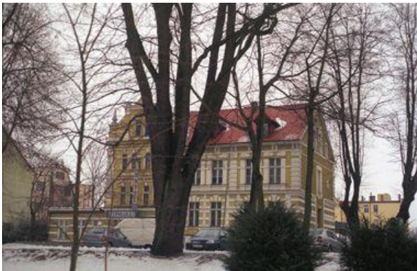
Blick zur Stellerstraße.
