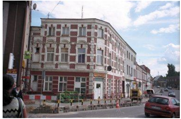
„Mehrgeschossiges Eckhaus mit Ziegelfassade an einer Strassenkreuzung in Tempelburg, davor Baustellenabspernung und parkende Autos, 2007. Farbaufnahme von 380 Pixel Breite.“ (Beschreibung des Herausgebers)
