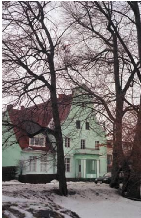
Häuser an der Stellterstraße.
