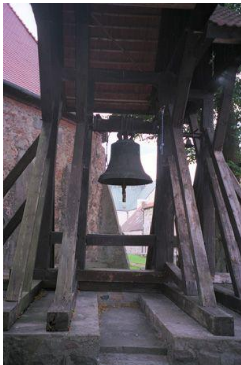
„Glocke im hoelzernen Glockenstuhl des freistehenden Turms bei der Dreifaltigkeitskirche Tempelburg, 2007. Hochformat von 300 Pixel Breite.“ (Beschreibung des Herausgebers)
