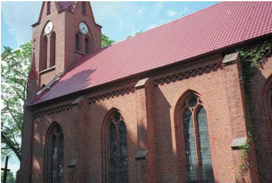
„Backsteinkirche von Luemzow mit Turmuhr, rotem Dach und Spitzbogenfenstern, 2007. Farbaufnahme von 600 Pixel Breite.“ (Beschreibung des Herausgebers)
