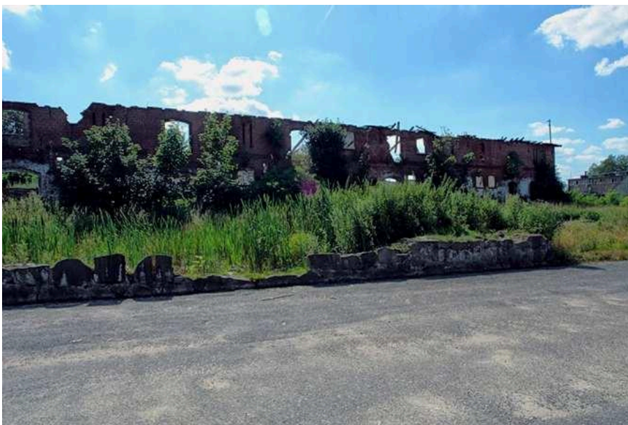
38 - Bärwalde, Gut Orth - hier arbeitete Opa Hugo Fritzke
