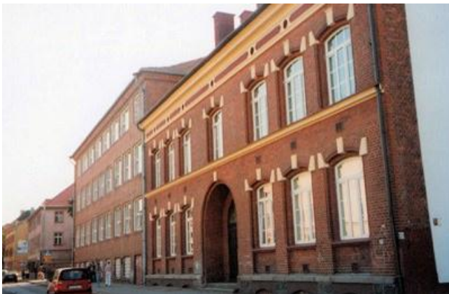
Die Friedrichschule von der Friedrichstraße aus gesehen.
