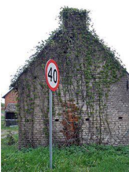
11 - Keller+Waschküche zu Gumz/Hackbarth
