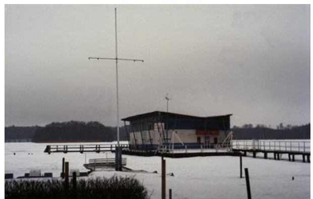
Das Bootshaus wurde inzwischen abgerissen.
