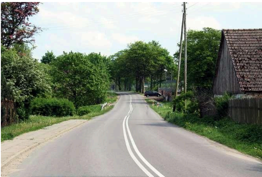
19 -Blick von Lucknitz in Richtung Bärwalde.
