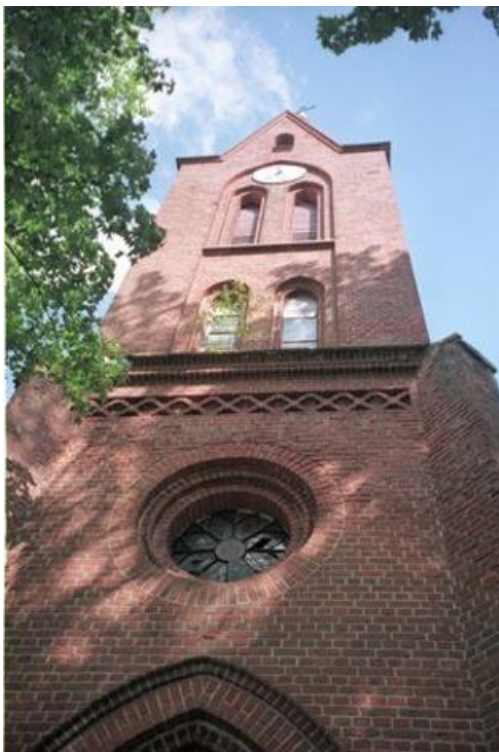
„Backsteinturm der Kirche von Lümmow mit Rundfenster und Blendbogenfries von unten aufgenommen, 2007. Hochformat von 314 Pixel Breite.“ (Beschreibung des Herausgebers)
