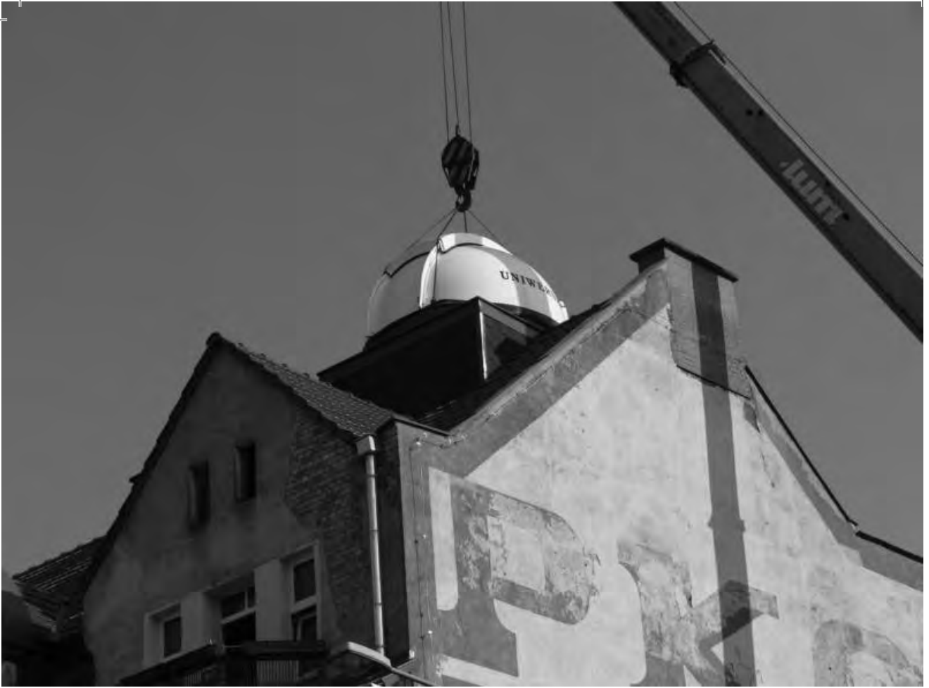
Montage der Observatoriumskuppel am 11. Juni 2007 Montaż kopuły obserwatorium w dniu 11 czerwca 2007 r.
