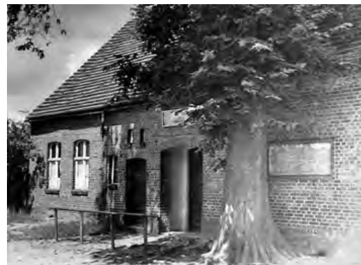
Bild 58: Schulgebäude 1968 - noch unverändert wie 1945
