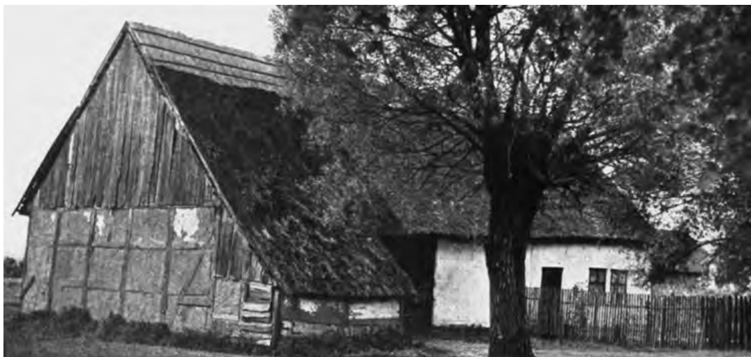
Bild 64: Friederizianisches Siedlungshaus in Auenfelde, 1938
