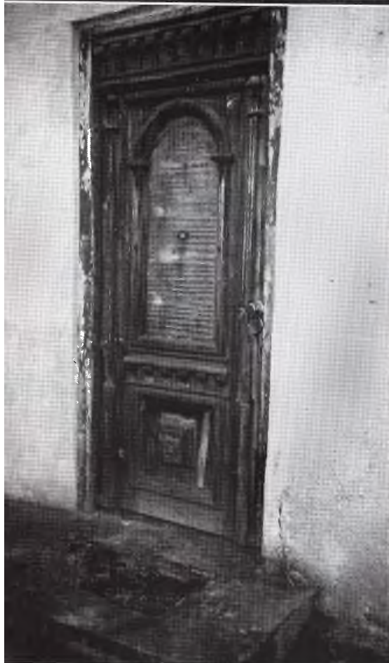
Wasserwerk Haus 3 b außen und innen
