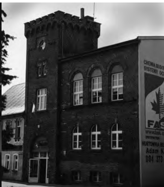
Bärwalde, ehemaliges Rathaus
