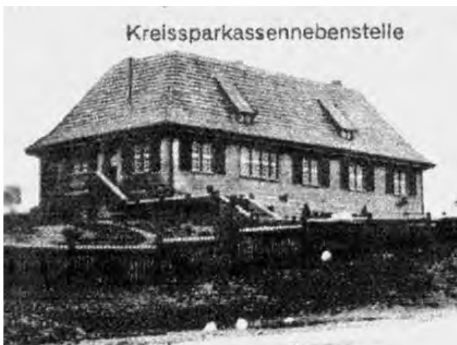
Bild 14: Ehemaliges Kreissparkassengebäude Haus der Frau Lüder (abgebrannt)
