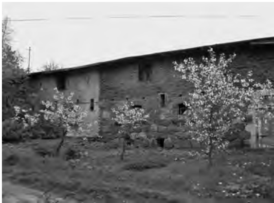
Bild 33: Ehemaliger umgebauter Viehstall 2010
