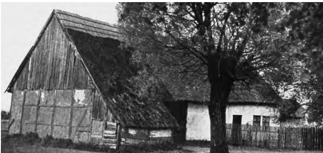
Bild 64: Friederizianisches Siedlungshaus in Auenfelde, 1938
