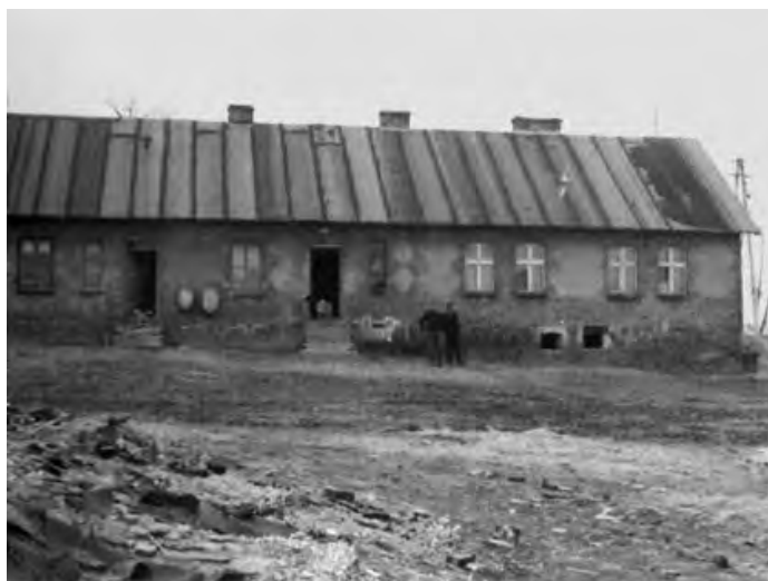
Bild 31: Arbeiterwohnungen, Zustand bis 1945
