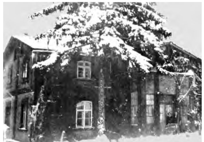
Bild 30: Wohnhaus, Zustand bis 1945
